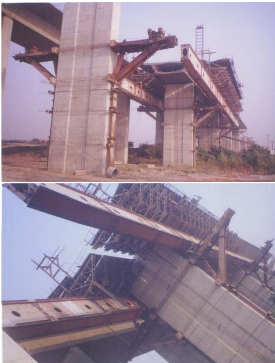
图 2 移动模架结构图
