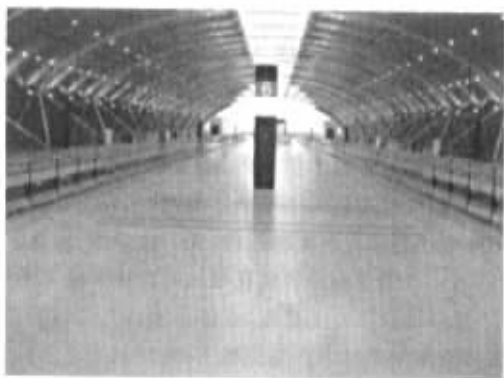
图 7 站台层橡胶地坪
