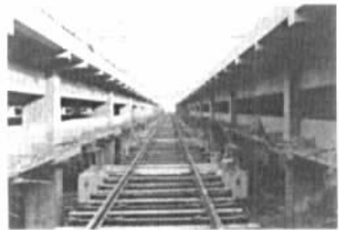
图 5 轨道梁滑道及后浇带留设
