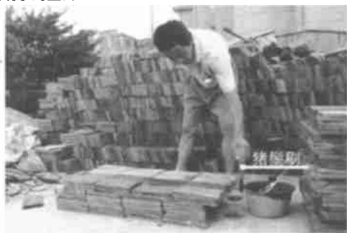
图7 第2次望砖刷水(居士林工地,施工方同图6)
