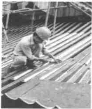
图 8 飞椽后尾望砖的铺设(居士林工地,施工方同图 6)
